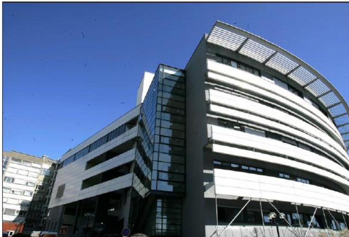
■ L'aile D de l'hôpital Bouloche est récente et pourrait, selon la CGT, accueillir des lits. Photo L. VADAM
